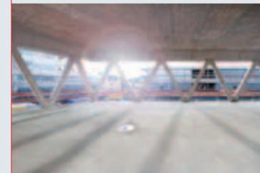
Das Obergeschoss der neuen Mensa der Hochschule Ruhr West wird im Eingangsbereich 10 m frei auskragen. Dies ermöglicht eine eigens dafür entworfene Stahlbetonfachwerkkonstruktion hinter der Fassade. Die Gesamtverformung des Fachwerkträgers wurde mit einem 3-D-FE-Modell entwickelt. Zur Reduzierung des Eigengewichts sind ferner Ortbetondecken mit Hohlkörpermodulen geplant. Die Hochschule Ruhr West ist eines der aktuellen Großprojekte, das Schübler-Plan mit der BIM-Methode plant und durchführt.
