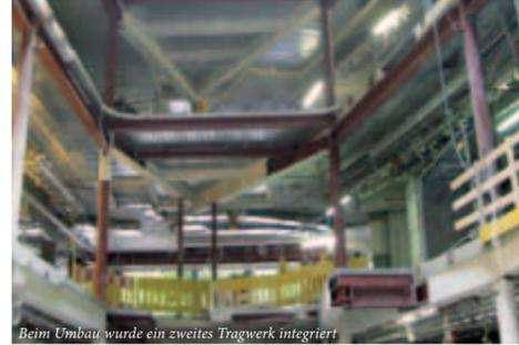
Beim Umbau wurde ein zweites Tragwerk integriert
