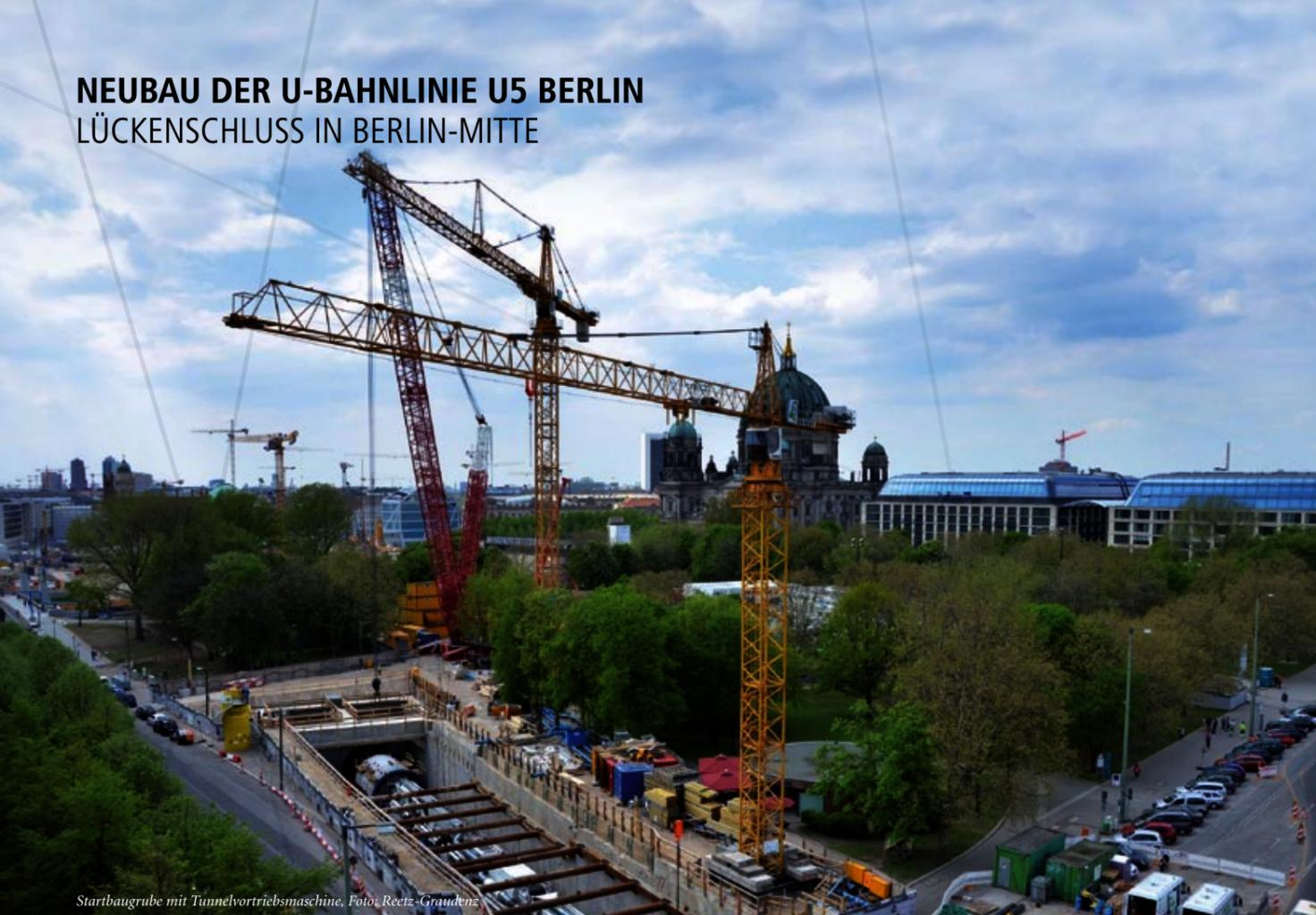
Startbaugrube mit Tunnelvortriebsmaschine. Foto: Reetz-Graudenz
