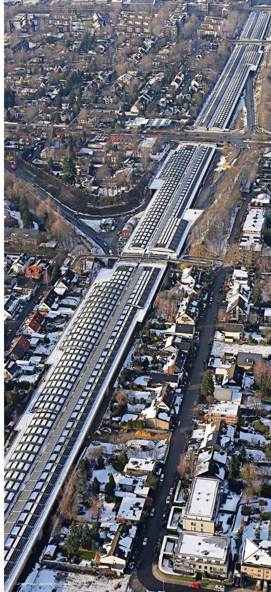
Lärmschutzeinhausung mit Stahl-Glas-Dach
